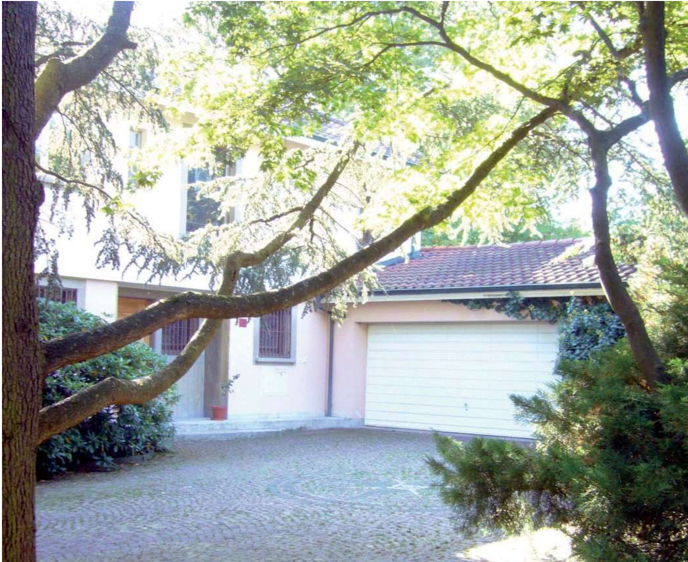
Vorplatz mit angebauter Doppelgarage
